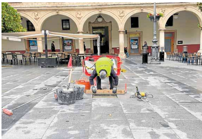
Reparación de acerado en la capital. IDEAL
